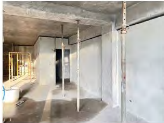
VISTA DE CONSTRUCCIONES EN PROCESO
