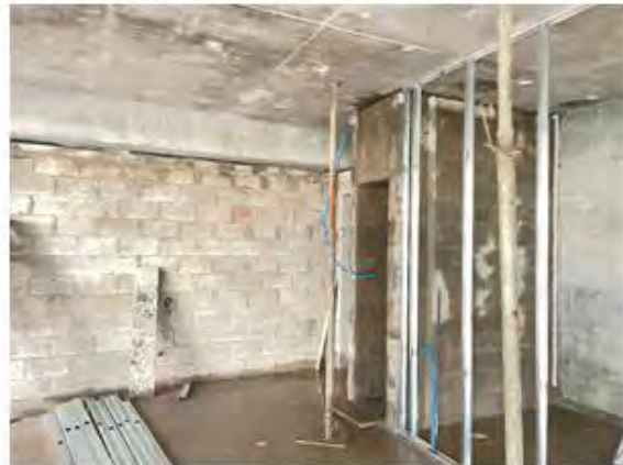
VISTA DE CONSTRUCCIONES EN PROCESO
