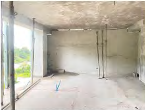
VISTA DE CONSTRUCCIONES EN PROCESO
