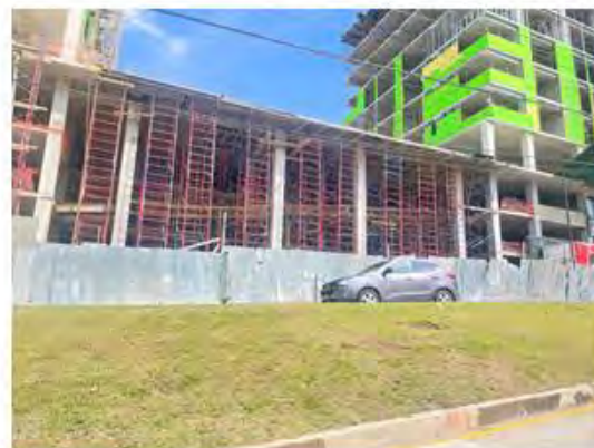
VISTA DE CONSTRUCCIONES EN PROCESO
