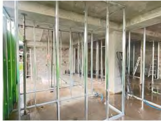
VISTA DE CONSTRUCCIONES EN PROCESO
