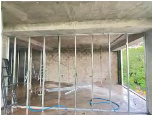
VISTA DE CONSTRUCCIONES EN PROCESO
