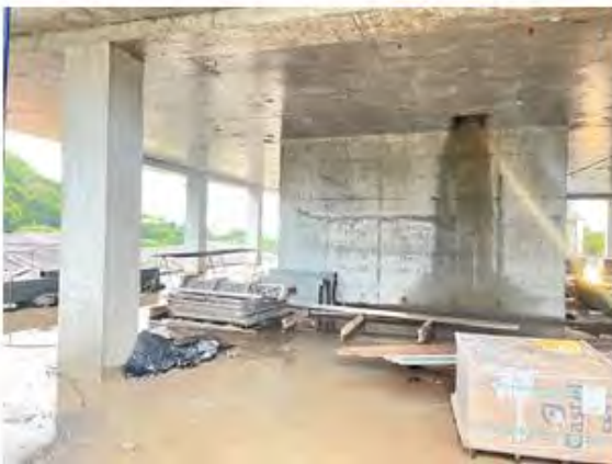
VISTA DE CONSTRUCCIONES EN PROCESO
