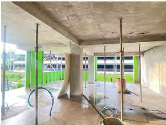
VISTA DE CONSTRUCCIONES EN PROCESO
