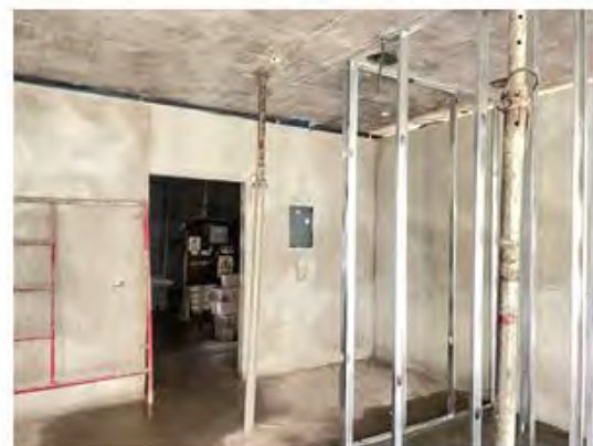
VISTA DE CONSTRUCCIONES EN PROCESO
