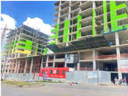
VISTA DE CONSTRUCCIONES EN PROCESO
