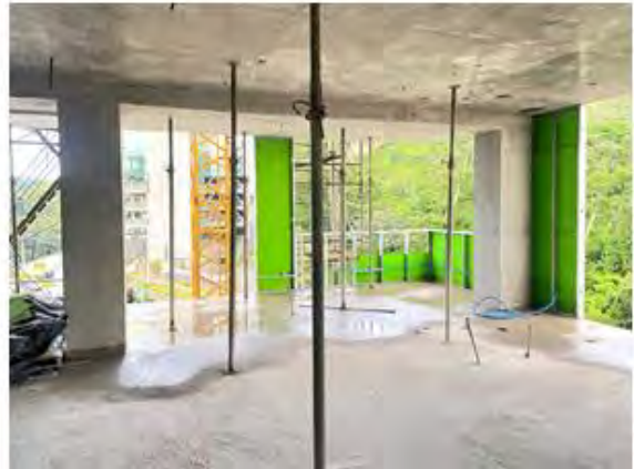
VISTA DE CONSTRUCCIONES EN PROCESO
