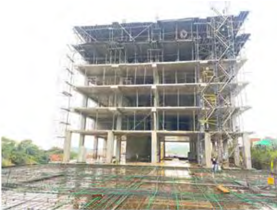
VISTA DE CONSTRUCCIONES EN PROCESO
