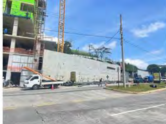
VISTA DE CONSTRUCCIONES EN PROCESO
