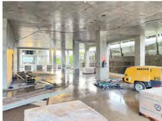
VISTA DE CONSTRUCCIONES EN PROCESO
