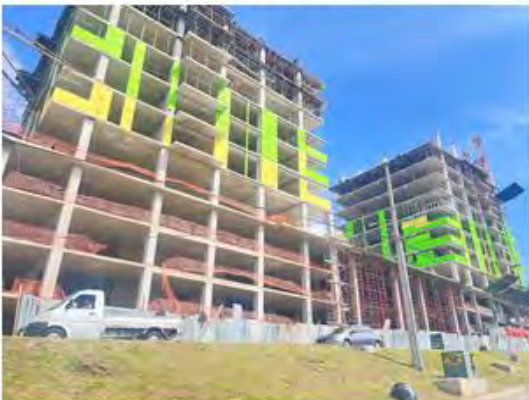
VISTA DE CONSTRUCCIONES EN PROCESO
