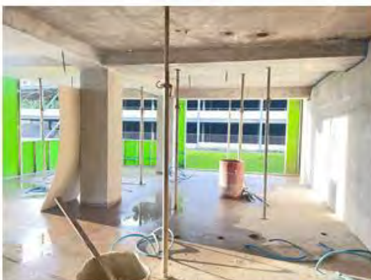
VISTA DE CONSTRUCCIONES EN PROCESO
