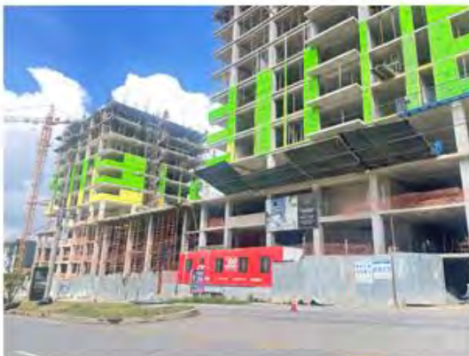
VISTA DE CONSTRUCCIONES EN PROCESO
